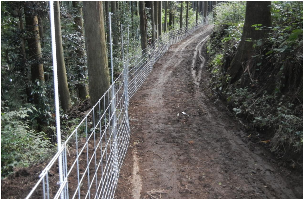
全長1.8kmにわたってきれいにフェンスを設置することができました
