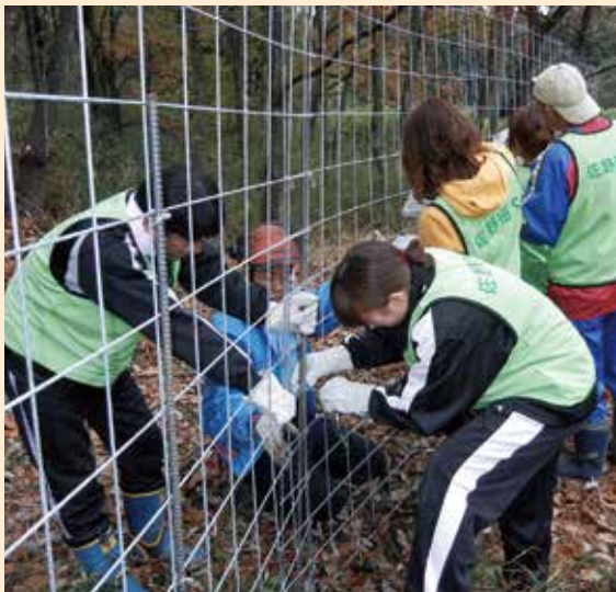
▲メッシュフェンス張り作業
