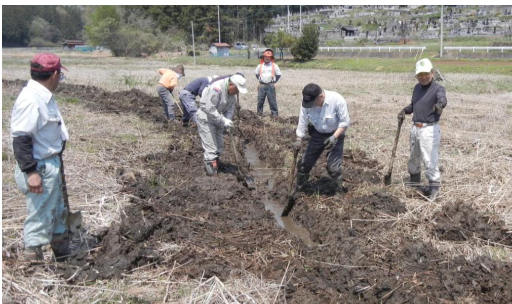
ほとんど泥で埋まってしまっていた土水路を水が流れるように復元しました
