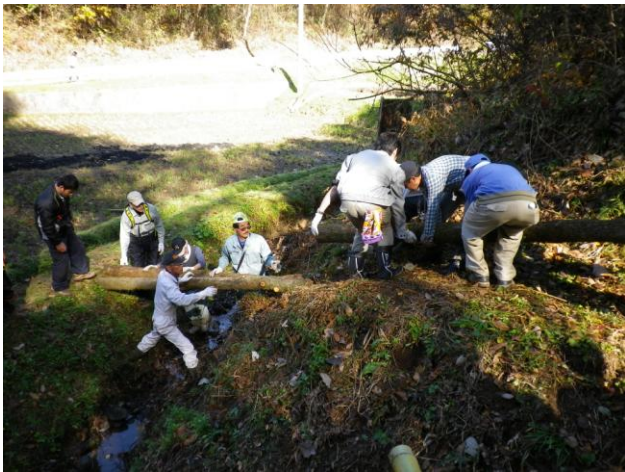
橋を架ける作業
