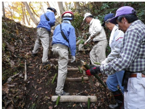
遊歩道の階段づくり作業
