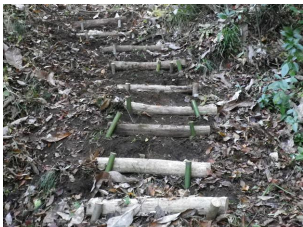
園児達が安全に通れる完成した階段
