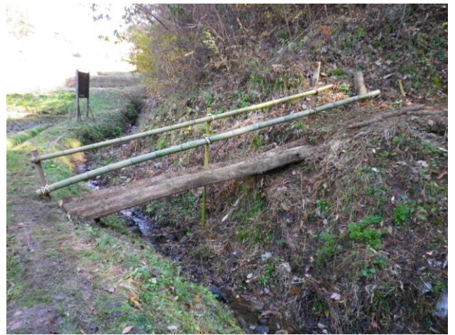
完成した丸太の橋
