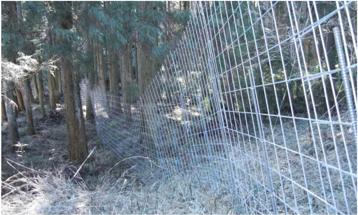
午前中 2 時間、午後 2 時間の作業で約 200m の柵を設置しました
