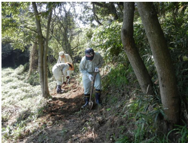
山道の修復現場。土砂が流れて堆積した土をスコップで除去していきます
