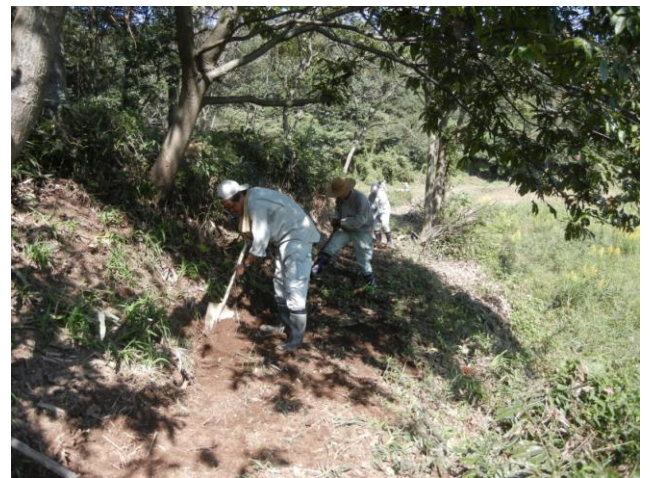
山道の修復現場。土砂が流れて堆積した土をスコップで除去していきます
