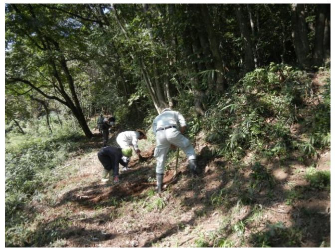
山道の修復現場。土砂が流れて堆積した土をスコップで除去していきます
