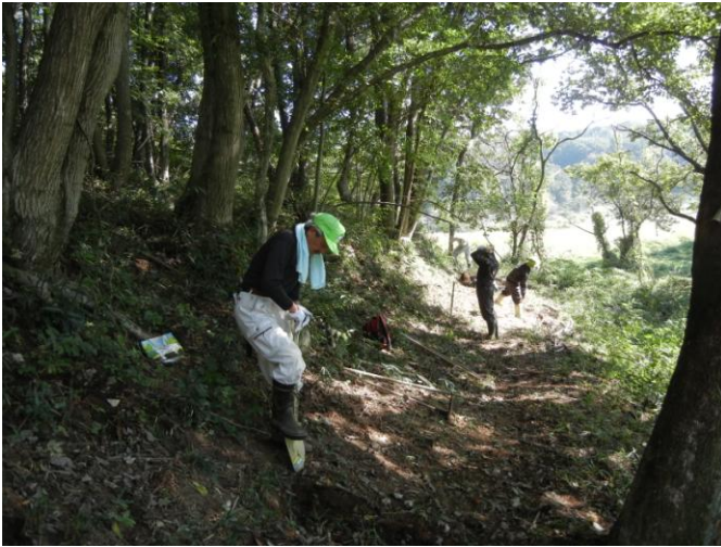
山道の修復現場。土砂が流れて堆積した土をスコップで除去していきます
