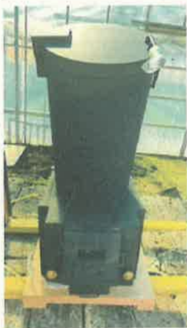
写真1 設置された薪ストーブ
