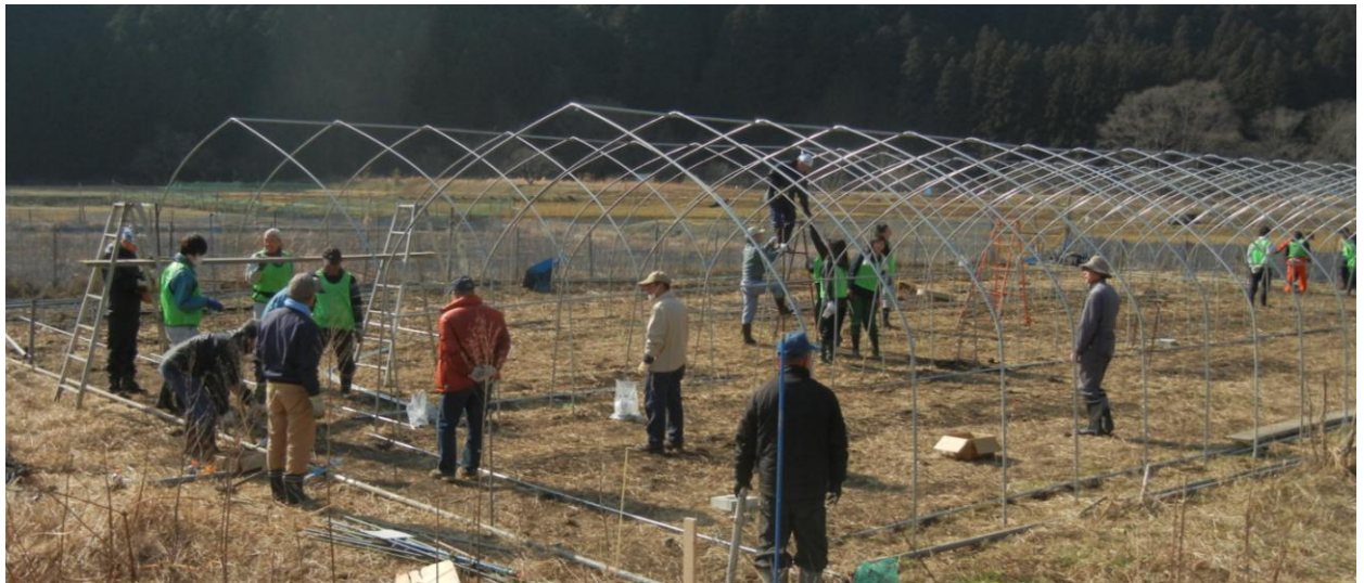
2棟のパイプハウスが組み立てられました
