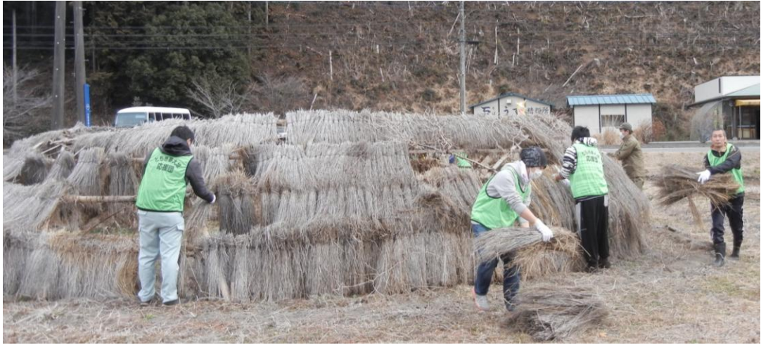
文星芸大生が2年前に稲わらと竹で作製したわらアートの解体・片付け作業
