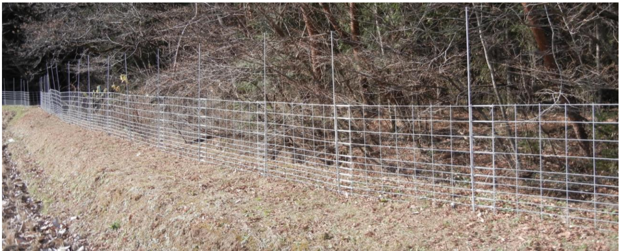
きれいに設置された防止柵
