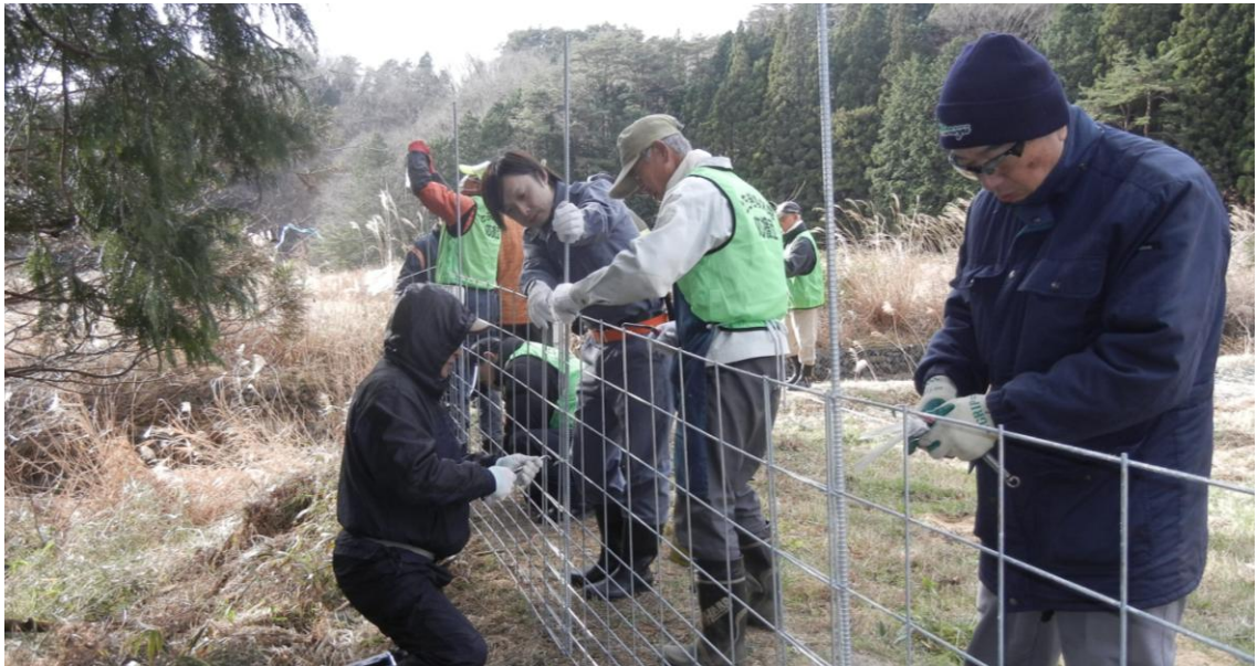
フェンスと鉄柱を結束する作業
