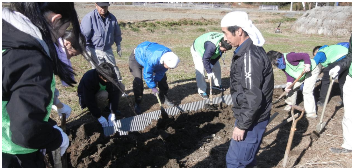
漏水防止シートを張る
