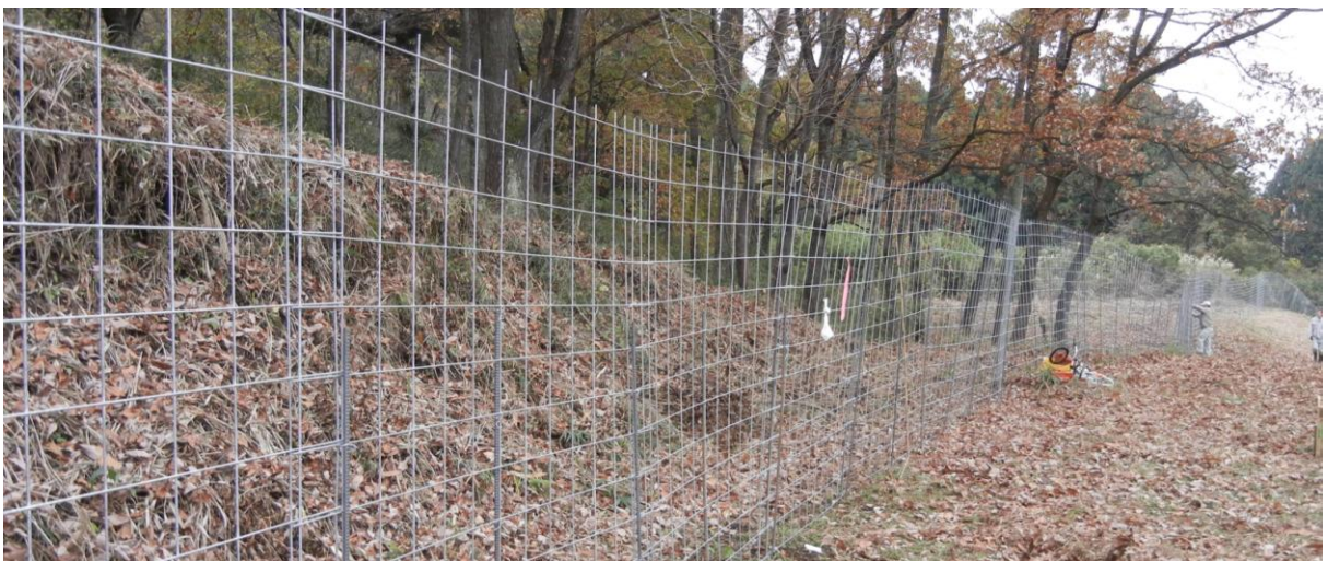
午前・午後約 3 時間の作業で約 300m にわたって柵を設置しました
