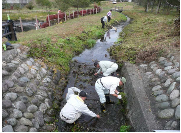
水路のゴミを除去する
